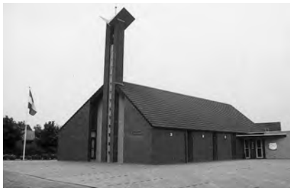
De nieuwe Eben-Haëzerkerk te Eemdijk.
