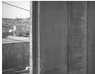
Afscheidingsmuur in aanbouw
